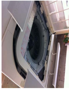
設備の取り外し
